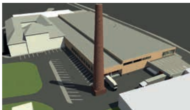
Jablonec nad Nisou Janovská 5178/39, Mšeno nad Nisou, 466 04 Jablonec nad Nisou Výrobní závod o velikosti 6500 m 2
